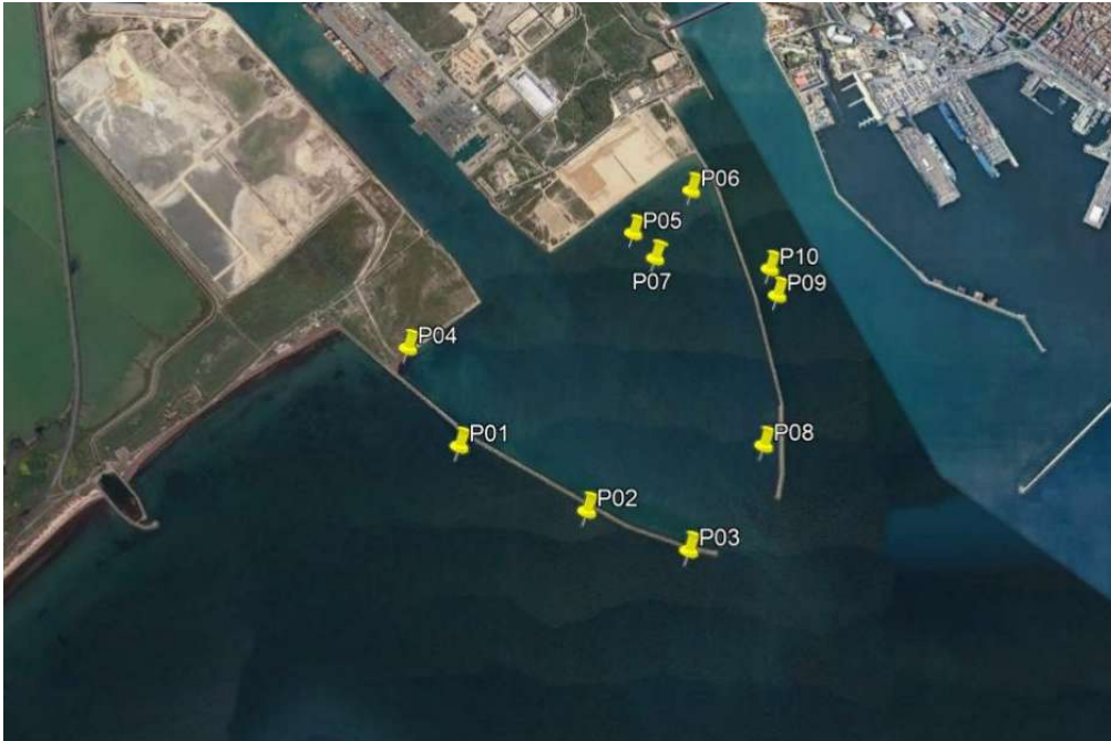
Fig. 6 - Ubicazione di tutte le stazioni di monitoraggio
