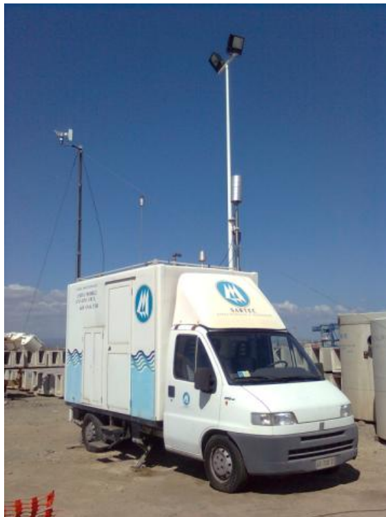
Figura 2.3 – Laboratorio mobile posizionato nel cantiere per il monitoraggio della qualità dell'aria
