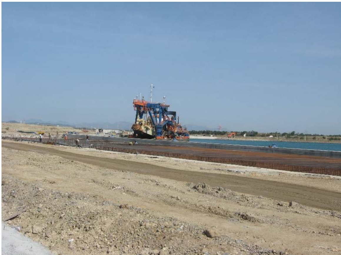
Fig. 3.2 - draga meccanica in azione nelle acque del Porto Canale
