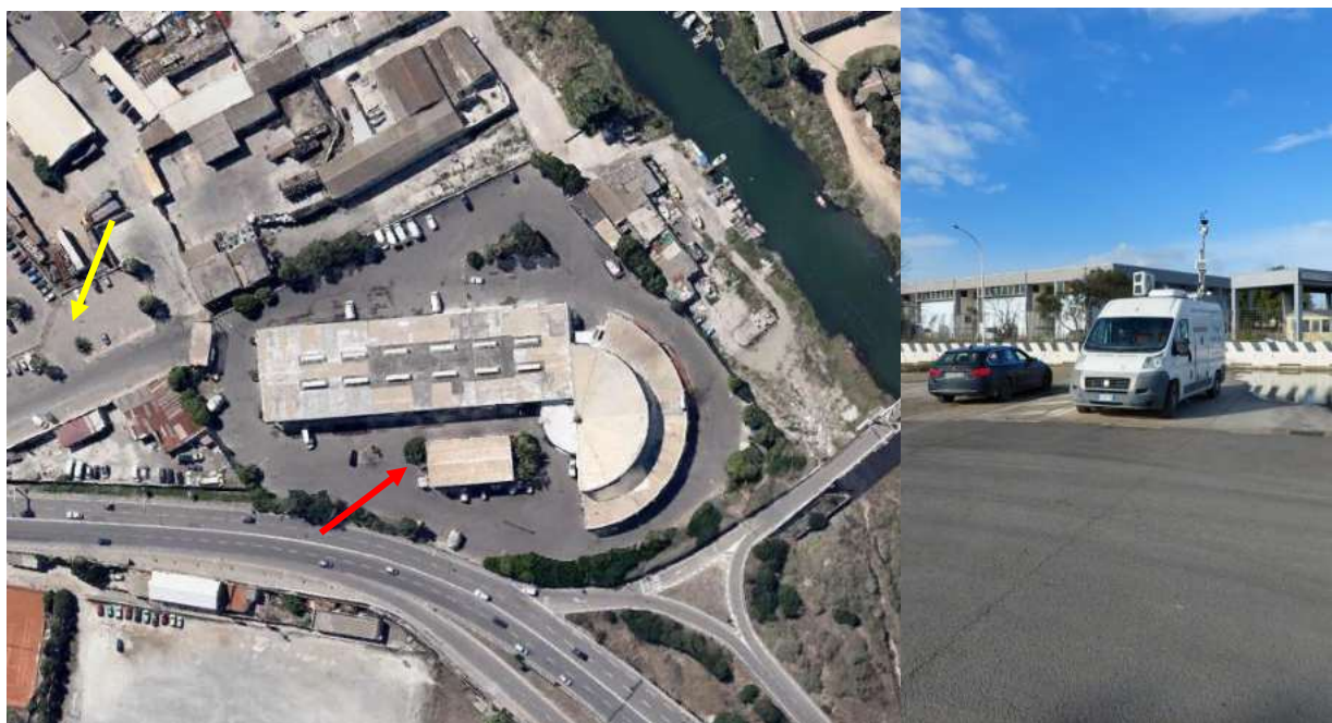
Figura 15: In rosso il punto indicato dal PMA, in giallo il nuovo punto.
