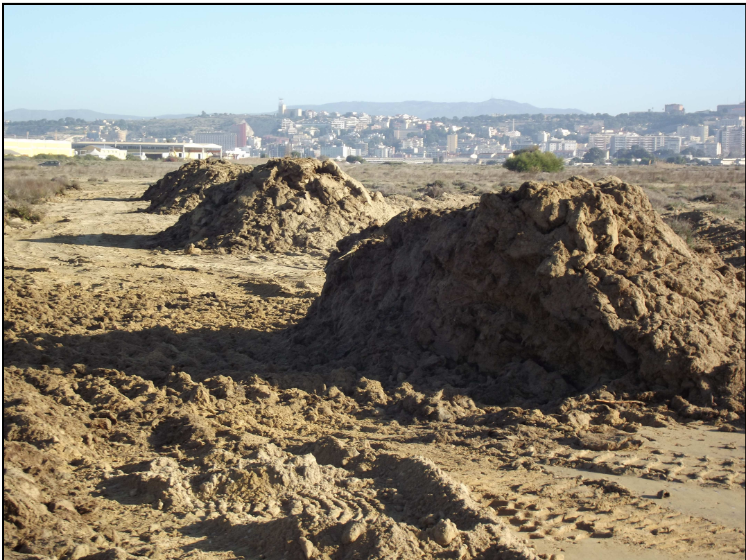
Fig. 15 – Limite dell'intervento, la terra viene successivamente distribuita negli spazi fra le zolle
