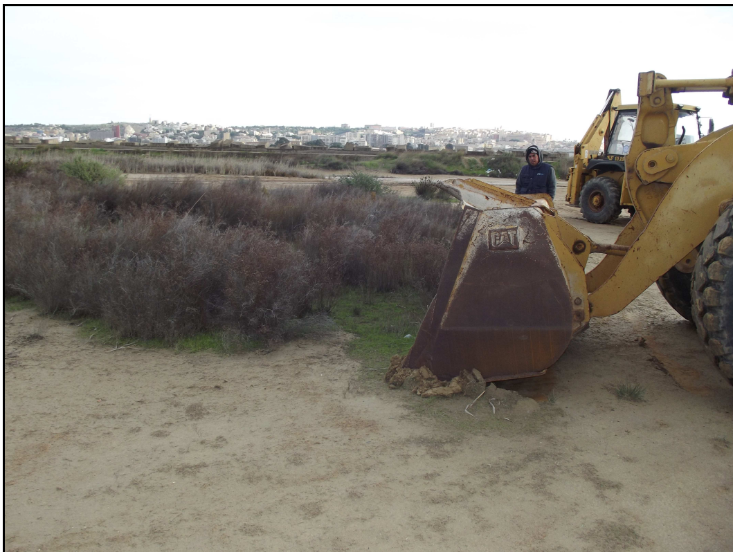
Fig. 2 – Inizio dei lavori
