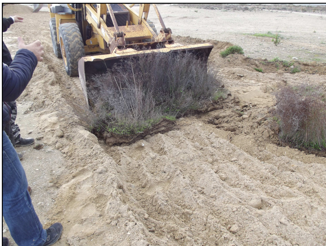
Fig. 9 – Riposizionamento della zolle
