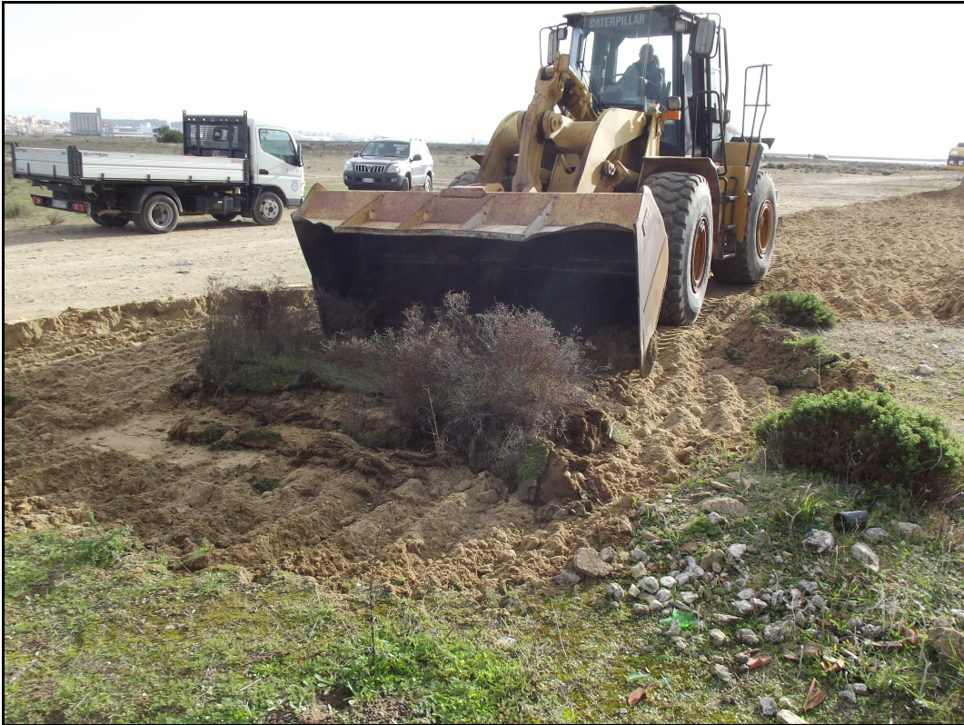
Fig. 6 – Riposizionamento della prima zolla
