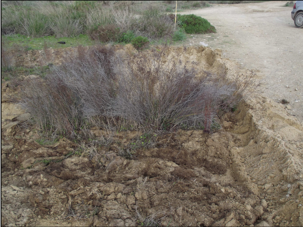
Fig. 10 – Riposizionamento della zolle
