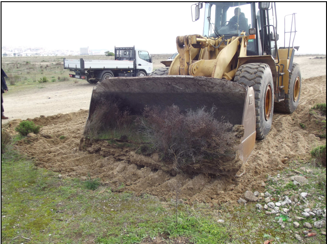
Fig. 5 – Riposizionamento della prima zolla
