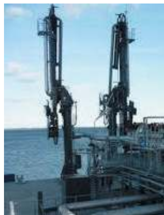
Bracci di carico di un deposito Gnl
