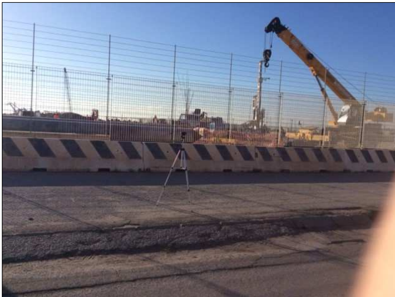
Vista della postazione di misura RSP4
