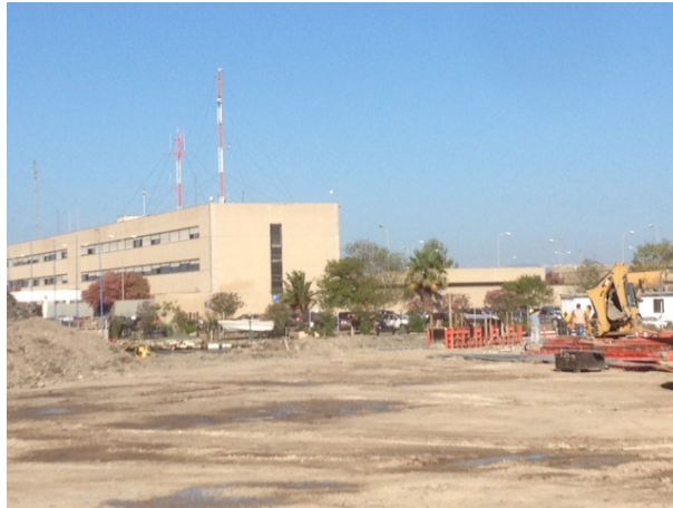
Foto 1: Vista di alcune fasi di cantiere
