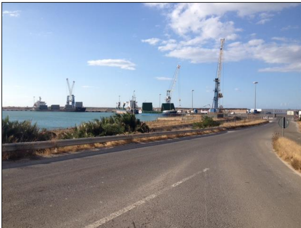
In figura: vista delle attività portuali svolte durante il sopralluogo.
