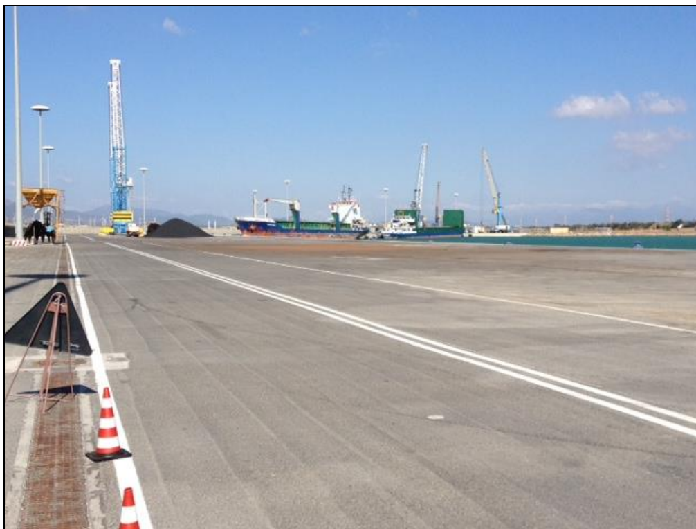
In figura: vista dell'attività di carico/scarico materiale sfuso e impiego della gru.
