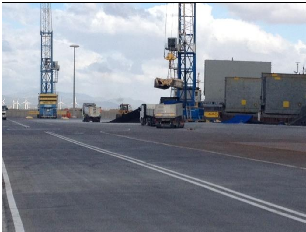
In figura: vista dell'attività di carico/scarico materiale sfuso.
