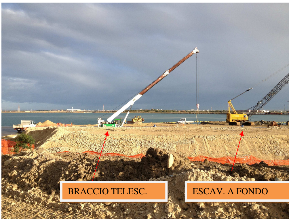
Foto 1: vista del braccio telescopico per la movimentazione del ferro e dell'escavatore a fondo
