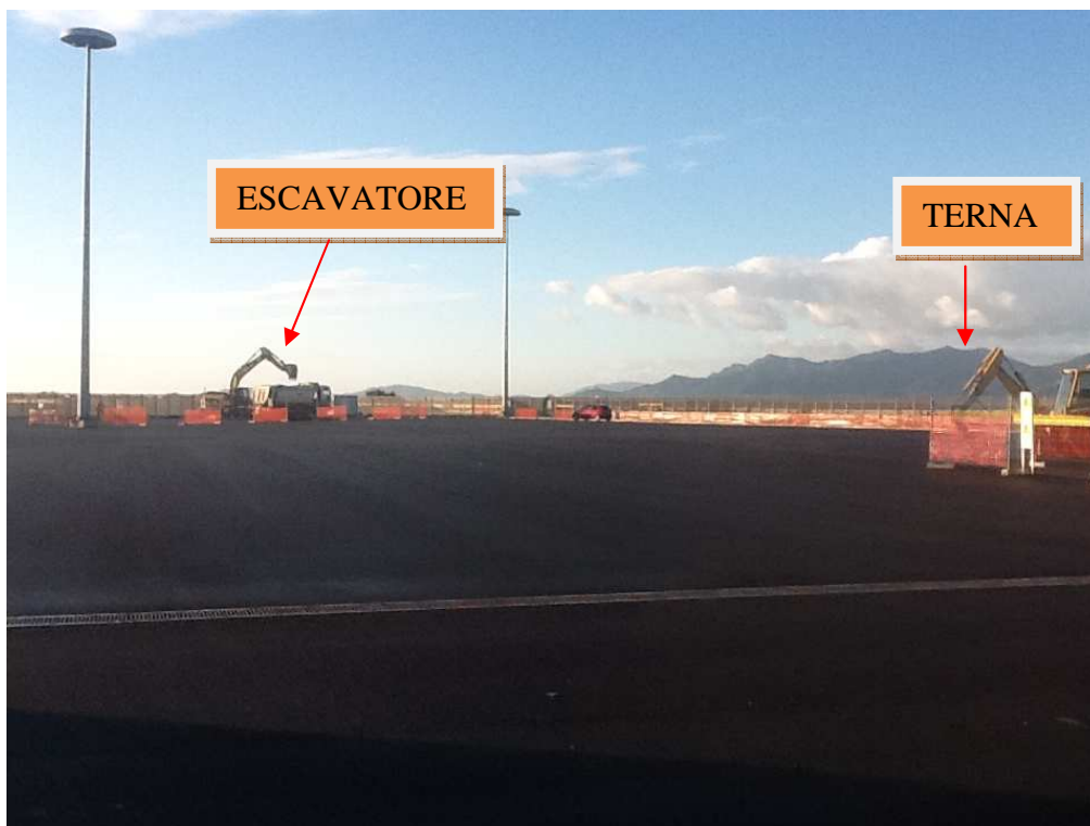
Foto 5: vista del cantiere ubicato sulla banchina facente parte del lotto "1"
