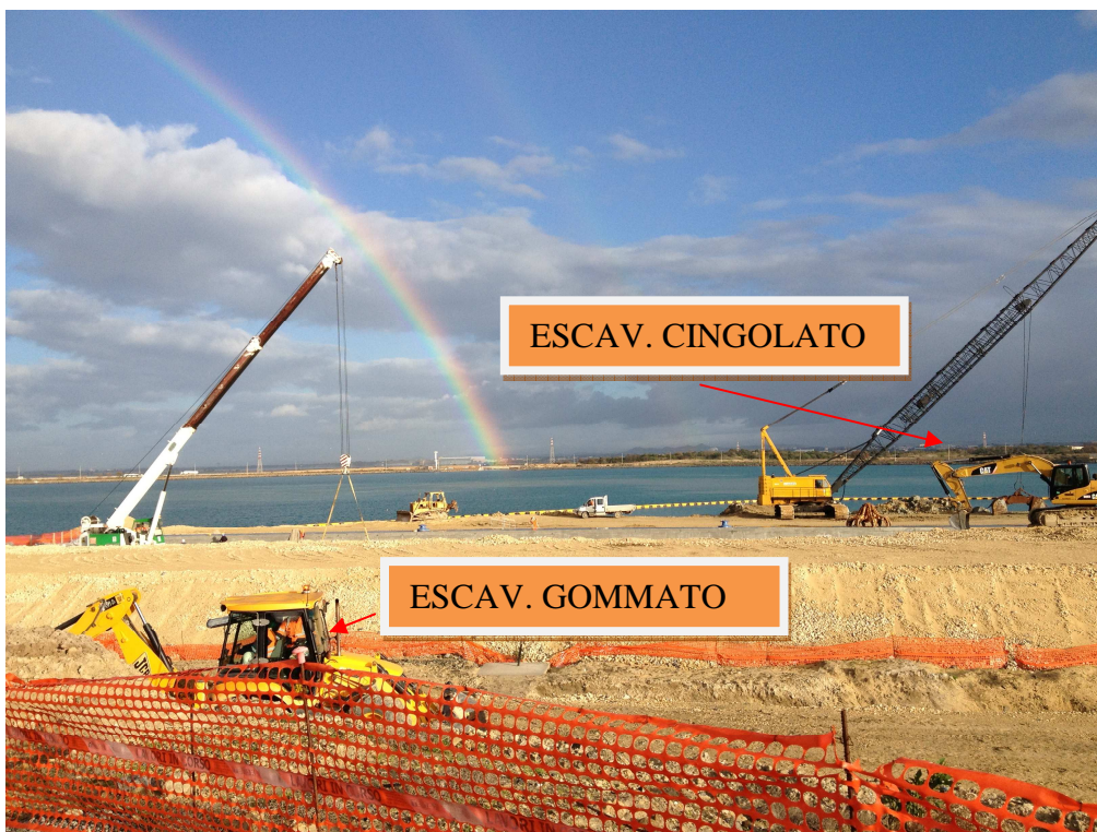
Foto 2: Vista dell'escavatore gommato e di quello cingolato
