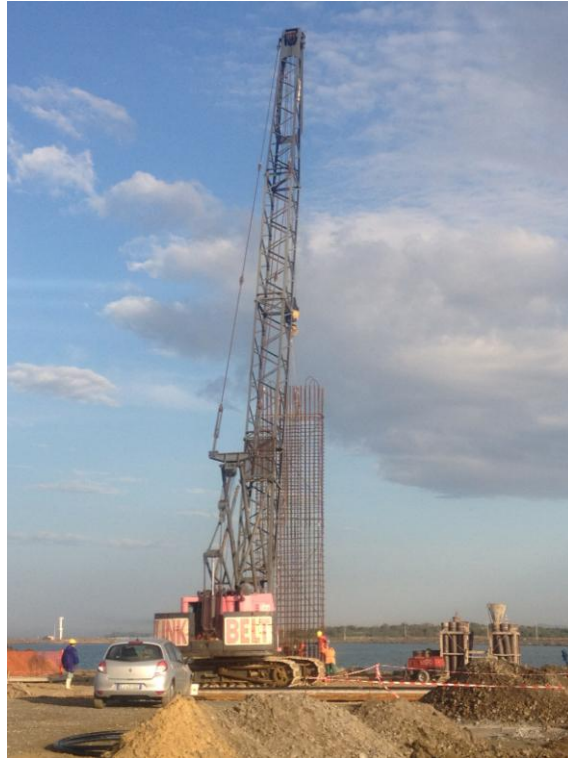
Foto 2: Vista Link Belt per movimentazione ferro
