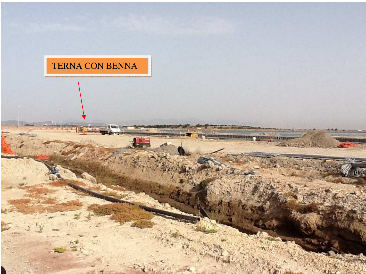
Foto 1: Vista della terna con benna al lavoro.
