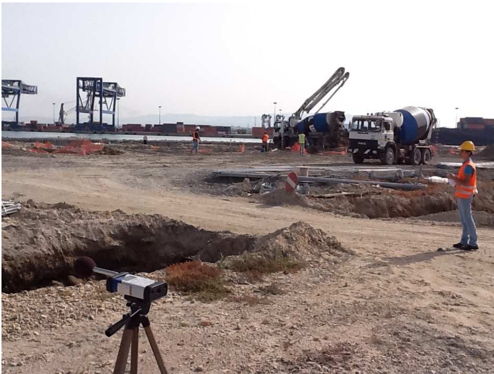
Foto 7 – Vista della postazione di misura RSP4
