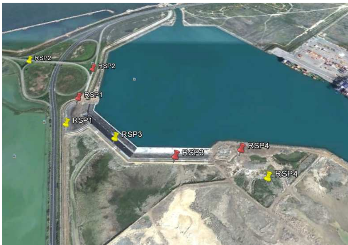
Ortofotogramma riportante l'ubicazione dei punti di misura (puntatore rosso postazione di misura impiegate, puntatore giallo postazioni di misura previste)
