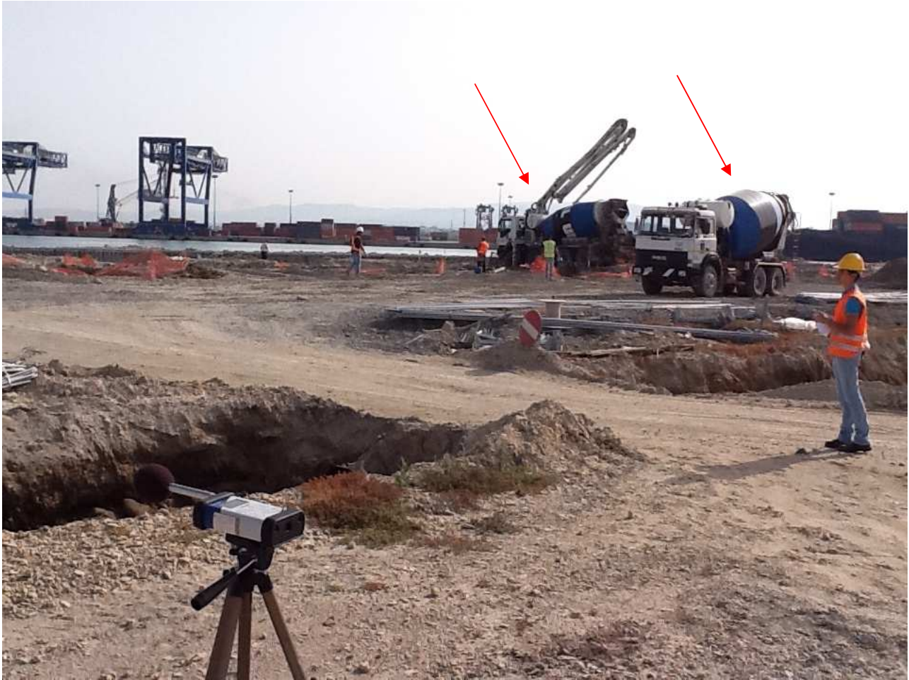
Foto 3: Vista dell'autobetoniera e dell'autopompa in funzione
