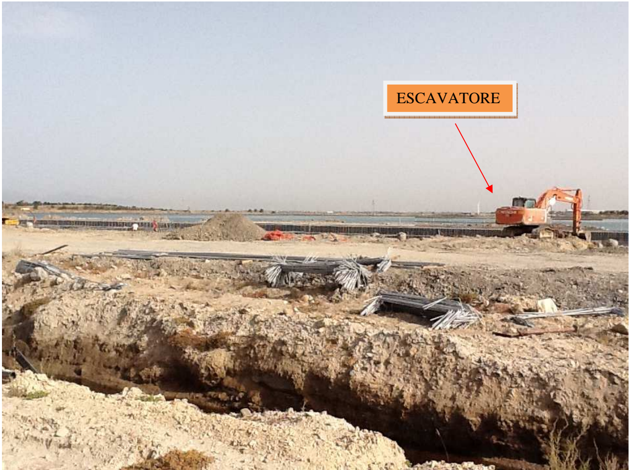
Foto 2: Vista dell'escavatore in funzione.
