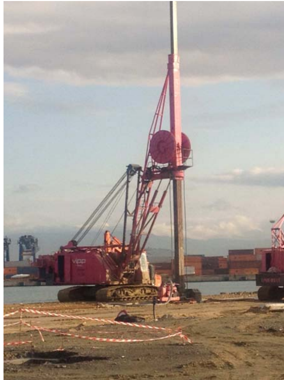
Foto 3: Vista dell'escavatore verticale
