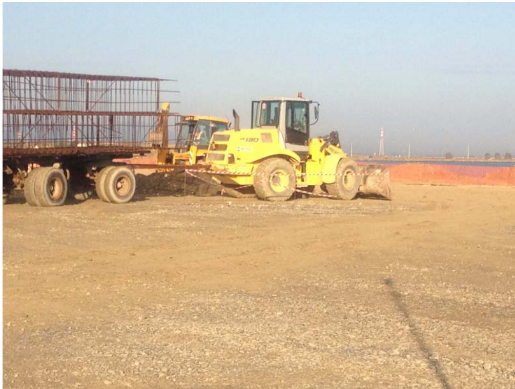
Foto 5: Vista della pala gommata
