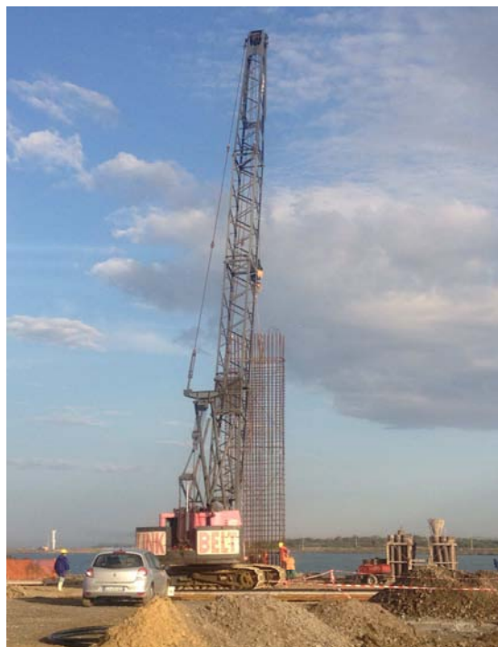
Foto 2: Vista Link Belt per movimentazione ferro
