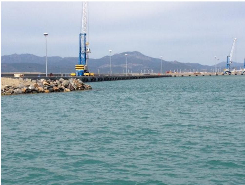
Foto 1: Vista lotto1 e lotto 2
