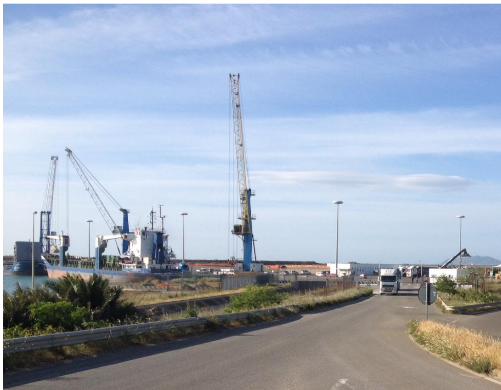
Foto 3: Vista attività di carico e transito automezzi sul lotto 1
