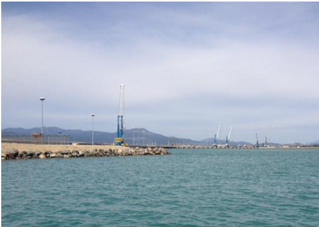
Foto 1: Vista lotto1 e lotto 2 attrezzati con gru mobili
