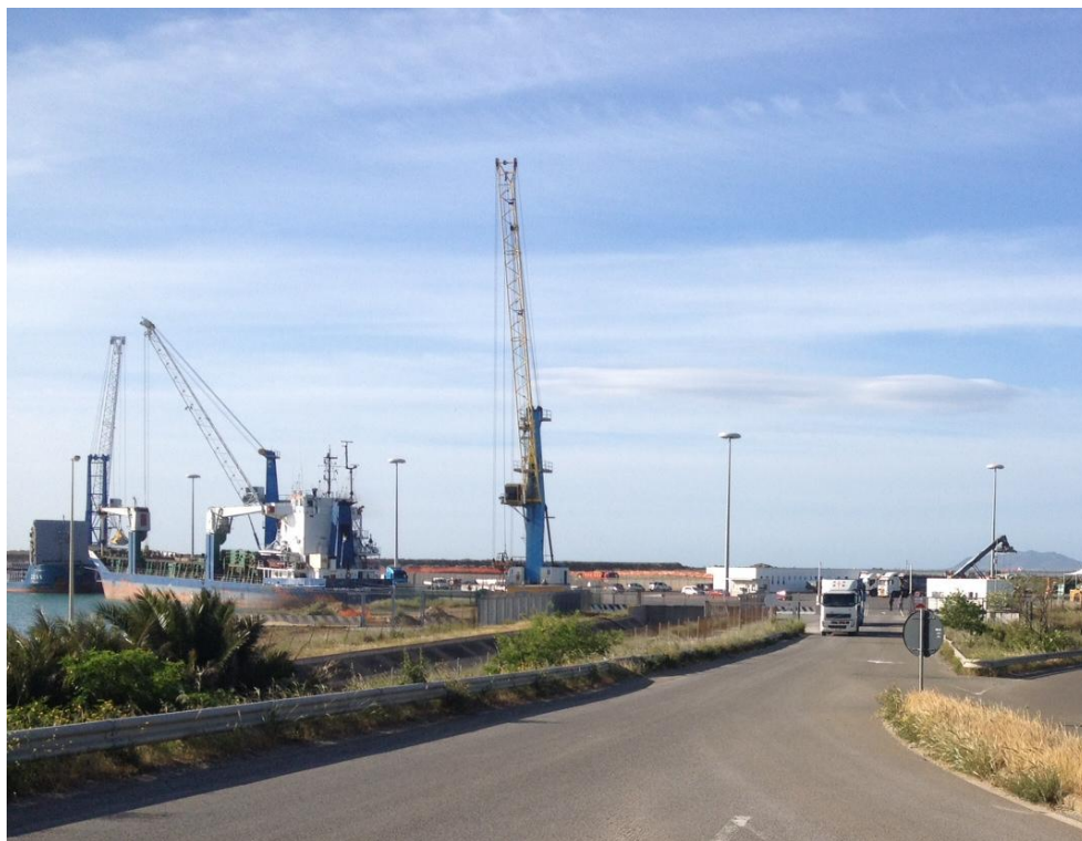
Foto 4: Vista attività di carico e transito automezzi sul lotto 1
