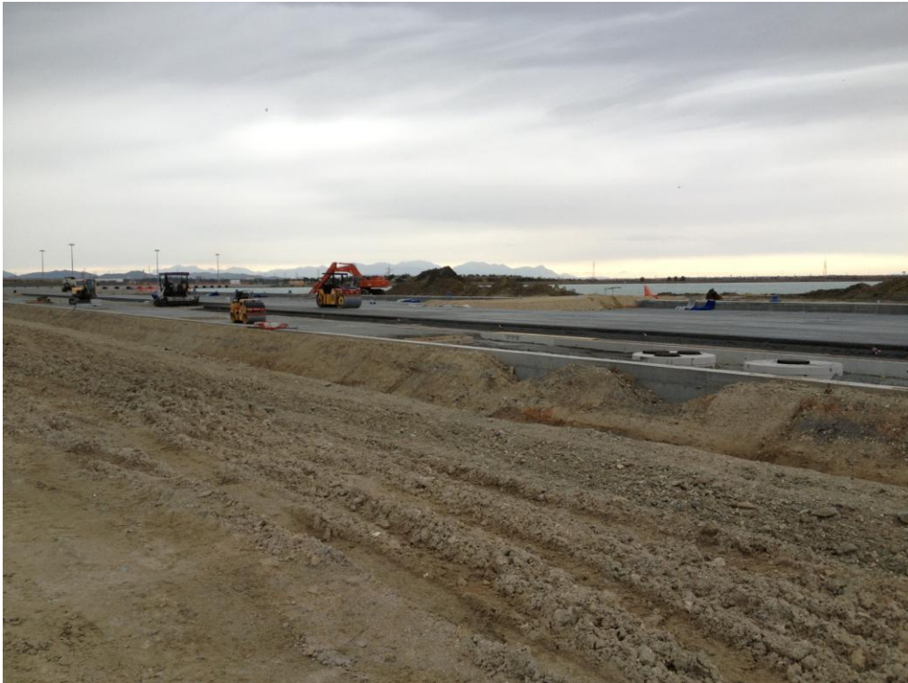
Foto 3: Vista ed evoluzione dei lavori in cantiere
