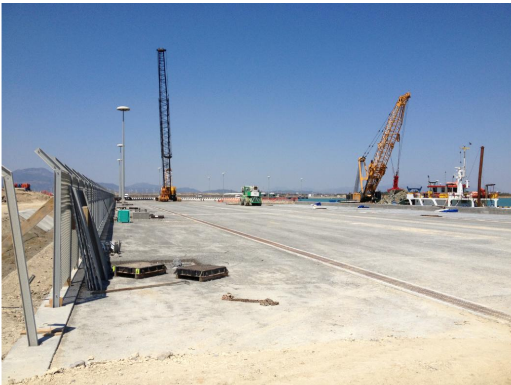
Foto 4: Vista ed evoluzione dei lavori in cantiere
