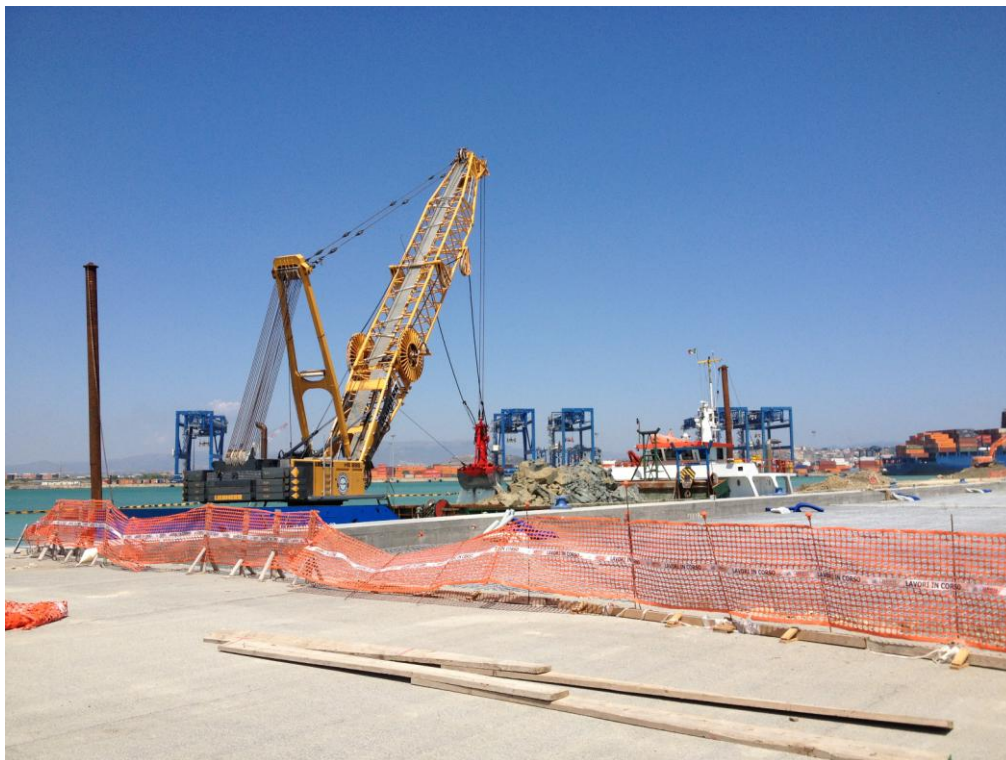
Foto 5: Vista ed evoluzione dei lavori in cantiere
