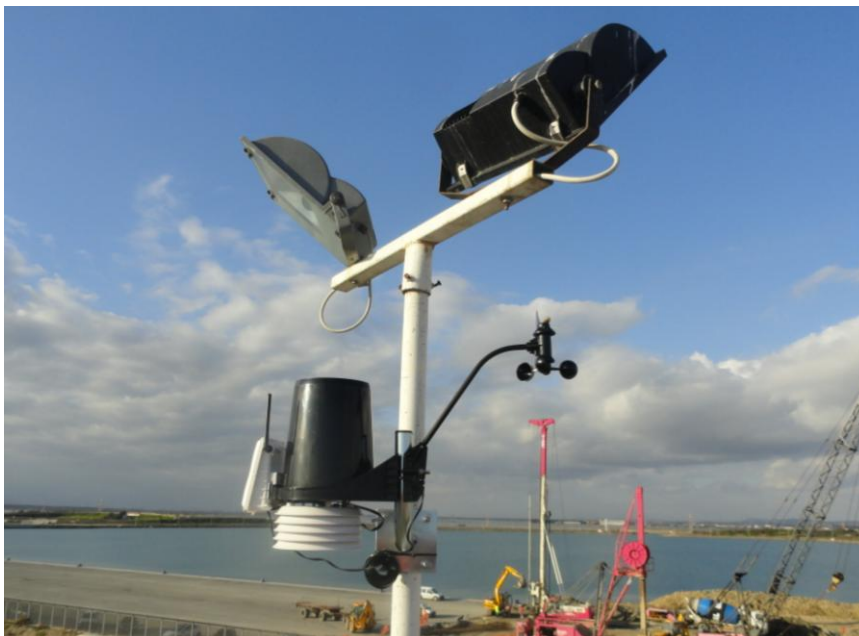
Foto 7: Centralina meteo fissa
