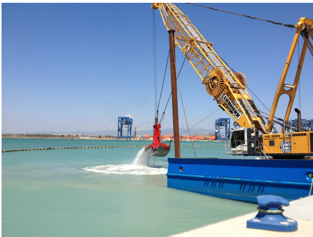
Foto 6: Vista ed evoluzione dei lavori in cantiere
