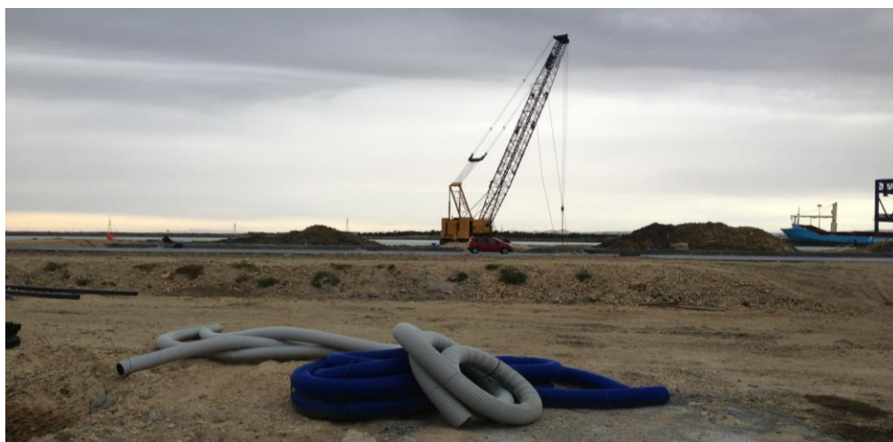
Foto 2: Vista ed evoluzione dei lavori in cantiere
