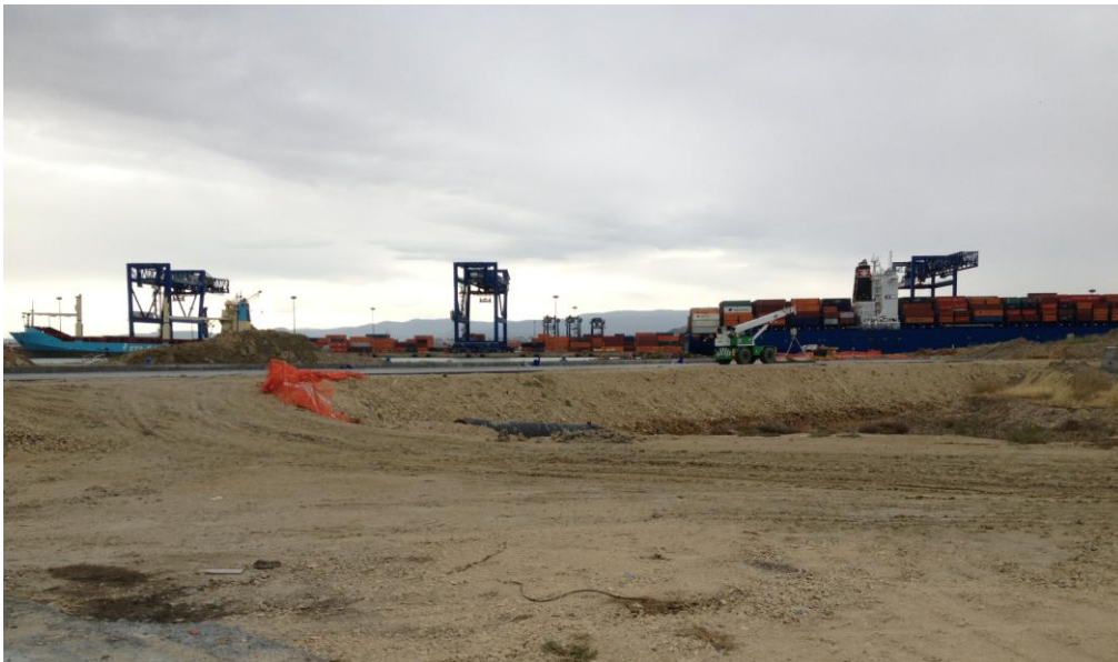
Foto 1: Vista ed evoluzione dei lavori in cantiere
