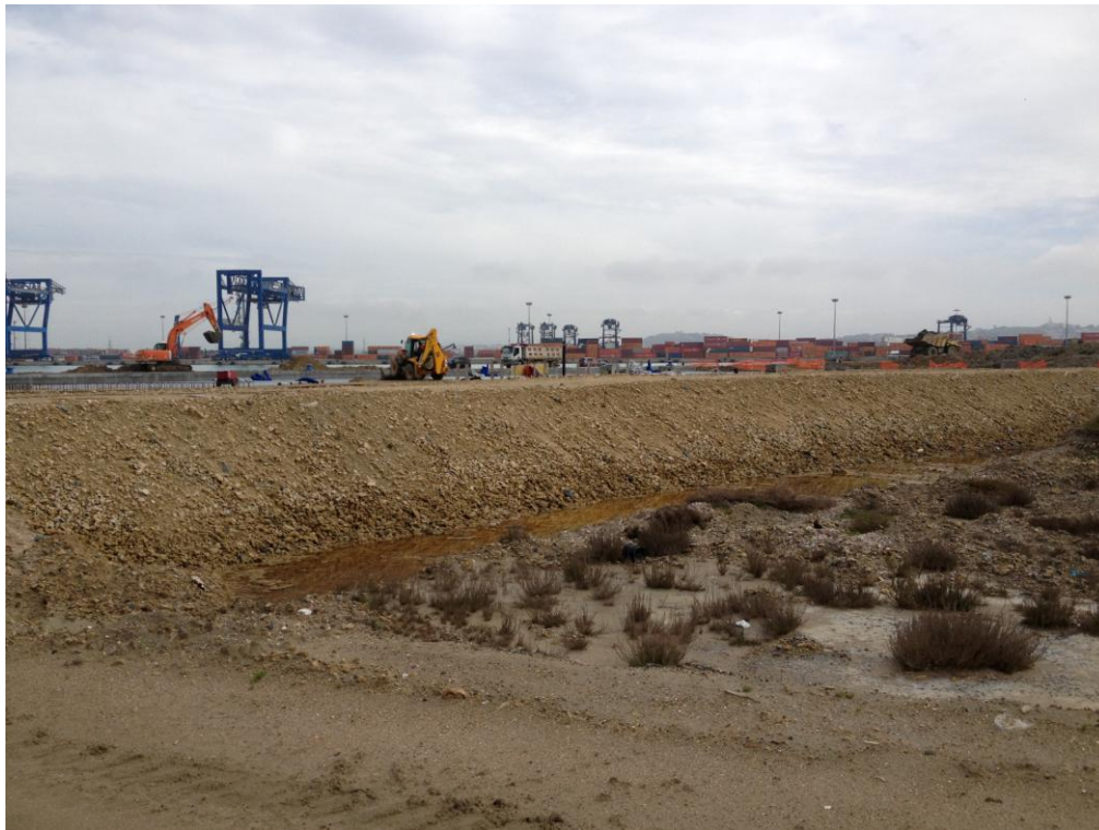
Foto 2: Vista ed evoluzione dei lavori in cantiere
