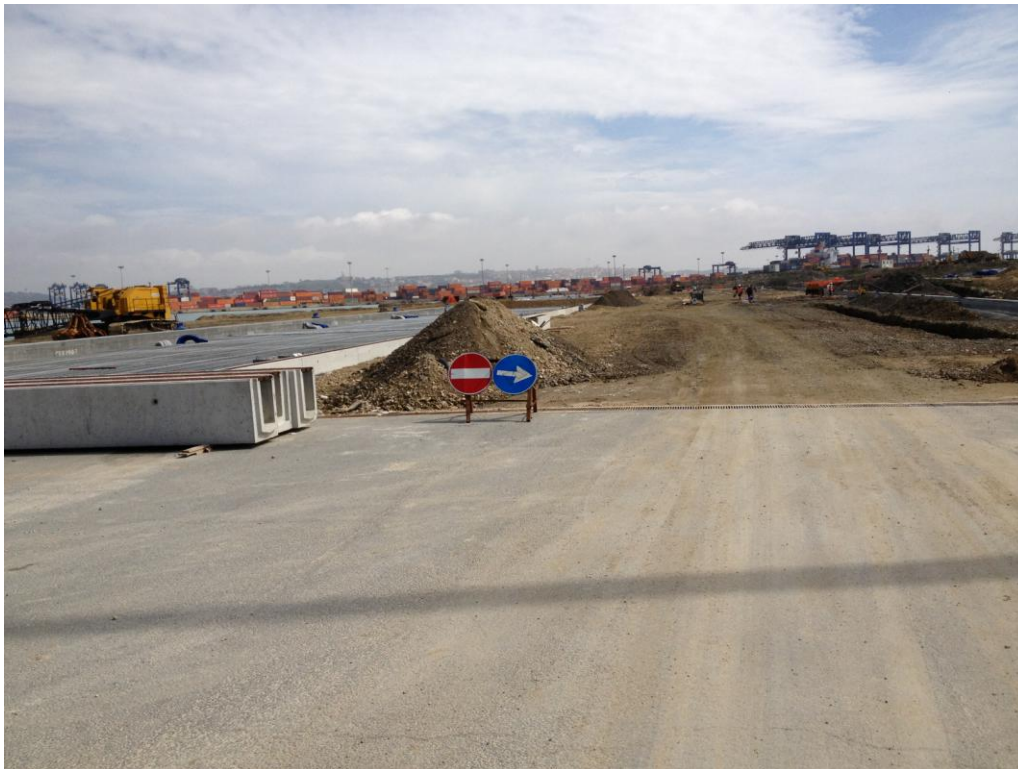
Foto 1: Vista ed evoluzione dei lavori in cantiere
