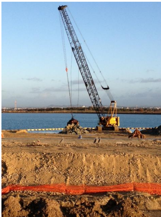
Foto 4: Vista delle operazioni di dragaggio
