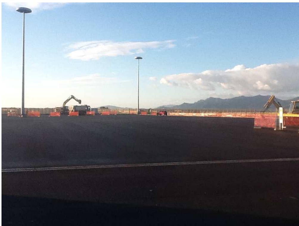
Foto 3: Vista del cantiere del Lotto 1
