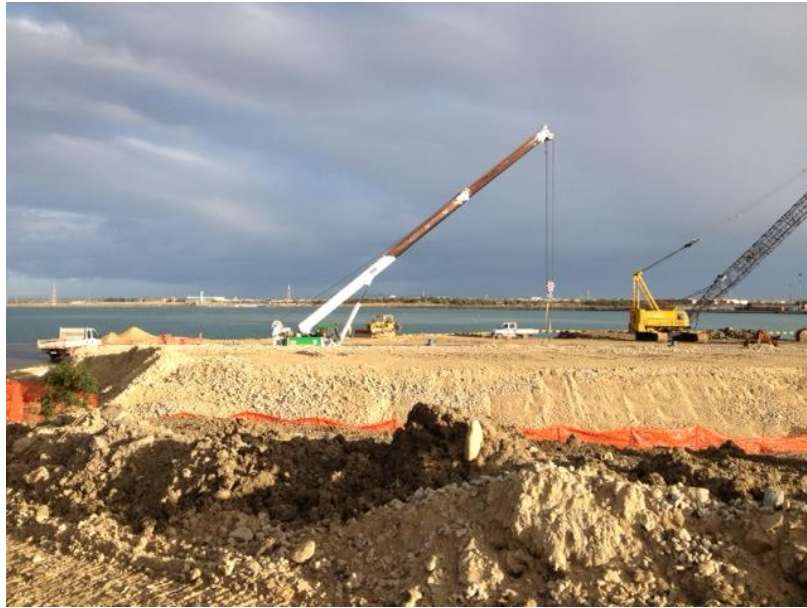
Foto 4: Vista della braccio telescopico e dell'escavatore a fondo
