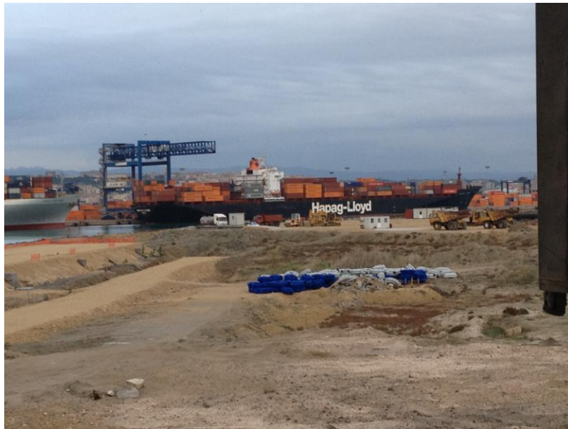
Foto 2: Vista pala cingolata, mezzi di cantiere e dumper
