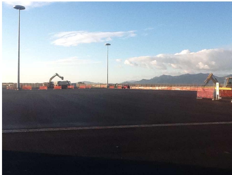
Foto 3: Vista del cantiere del Lotto 1
