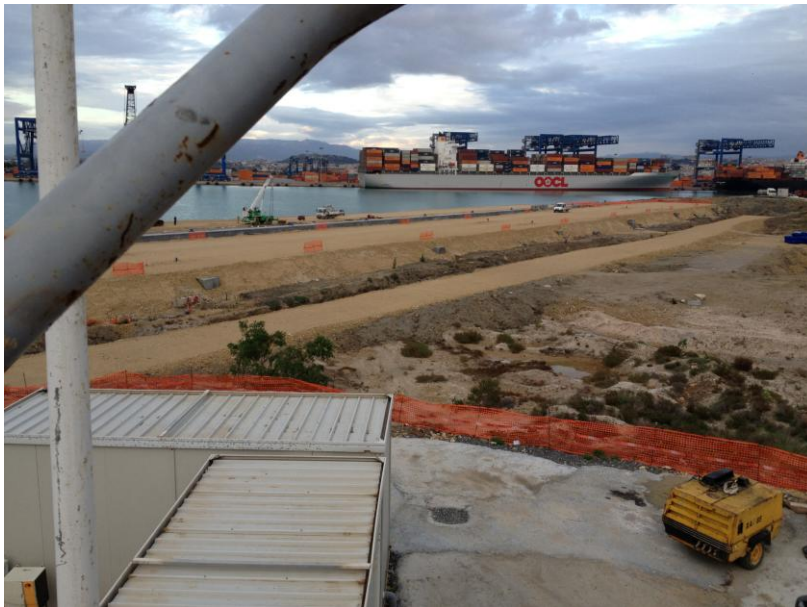
Foto 1: Vista ed evoluzione dei lavori in cantiere
