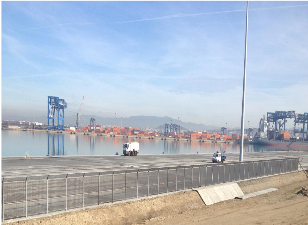
Foto 4: Vista ed evoluzione dei lavori in cantiere
