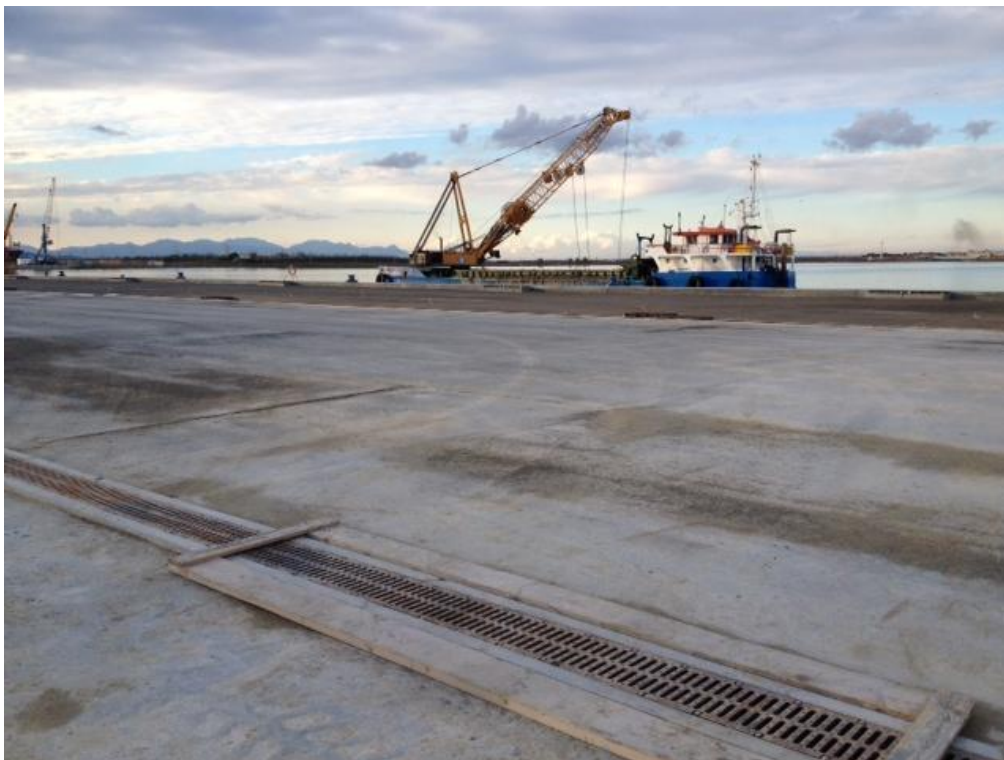
Foto 2: Vista ed evoluzione dei lavori in cantiere
