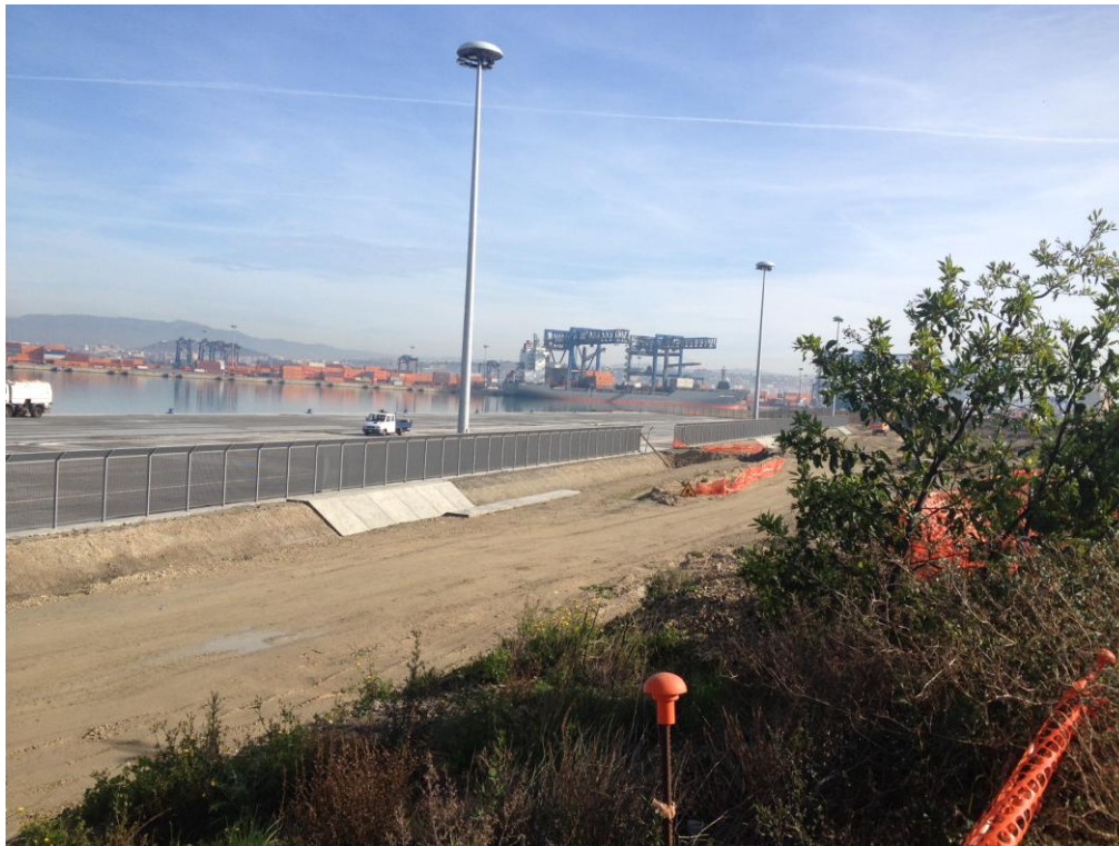
Foto 6: Vista ed evoluzione dei lavori in cantiere
