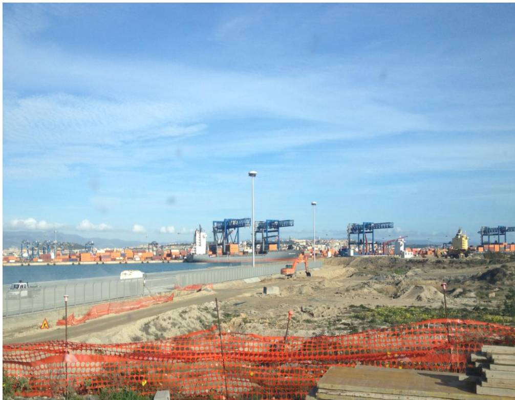
Foto 5: Vista ed evoluzione dei lavori in cantiere
