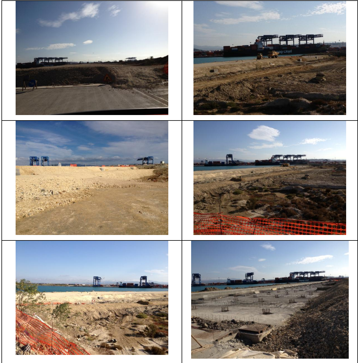
Foto 1: Vista ed evoluzione dei lavori in cantiere
