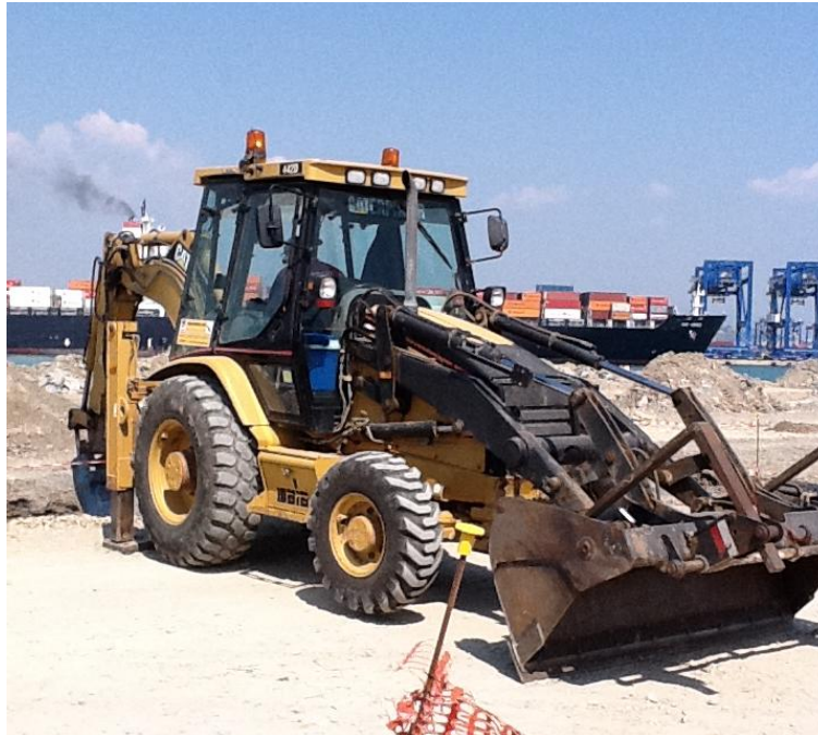
Foto 2: Vista della terna cat 442
